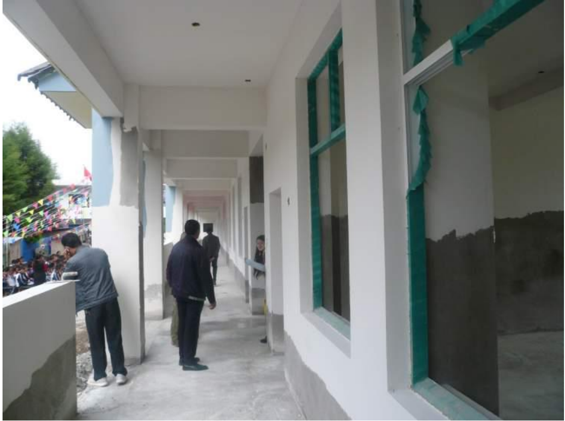
上：地下(一樓)走廊，門窗仍未裝上；下：其中一個教室內景。
