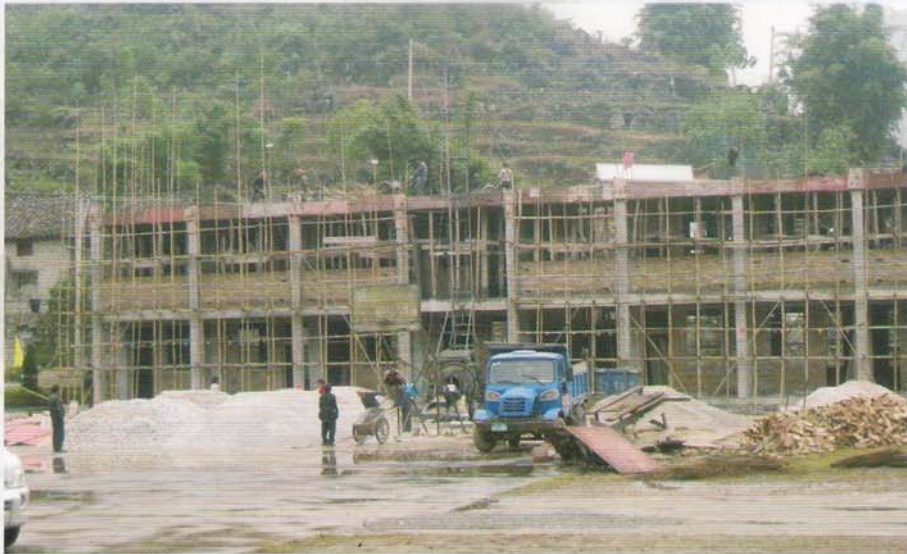
惠水县抵季乡翁吕小学新教学楼正在紧张施工中
