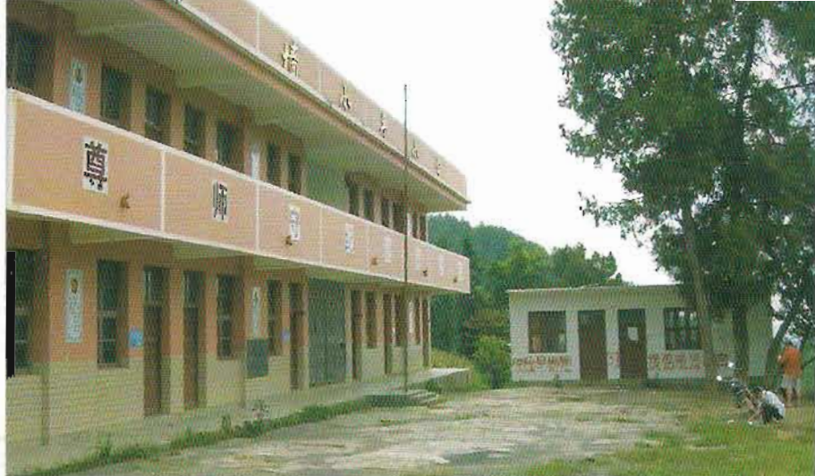
独山县打羊乡大石墙小平小学新教学楼
