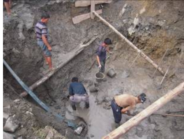
挖土建蓄水池
