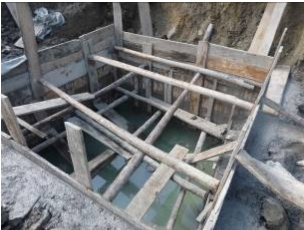
修建蓄水池壁
